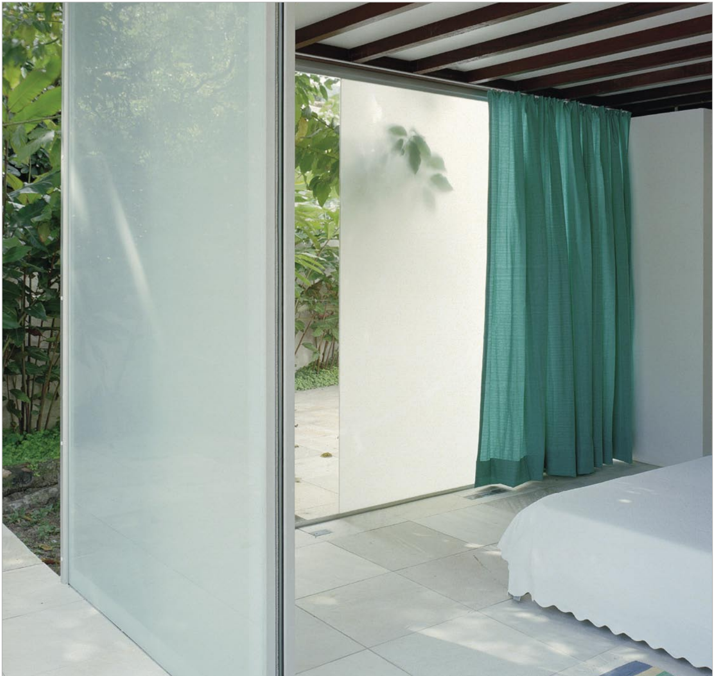
GLAZEN SCHUIFPUI Woning in Brazilië (architect Nitsche - fotograaf Nelson Kon). MATELUX Blank in gelaagde veiligheidsversie.
